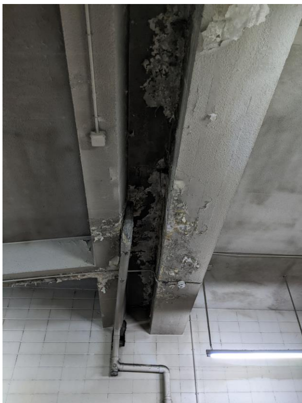
Foto 21. Humedades en vigas inicio rampa de entrada (2)
