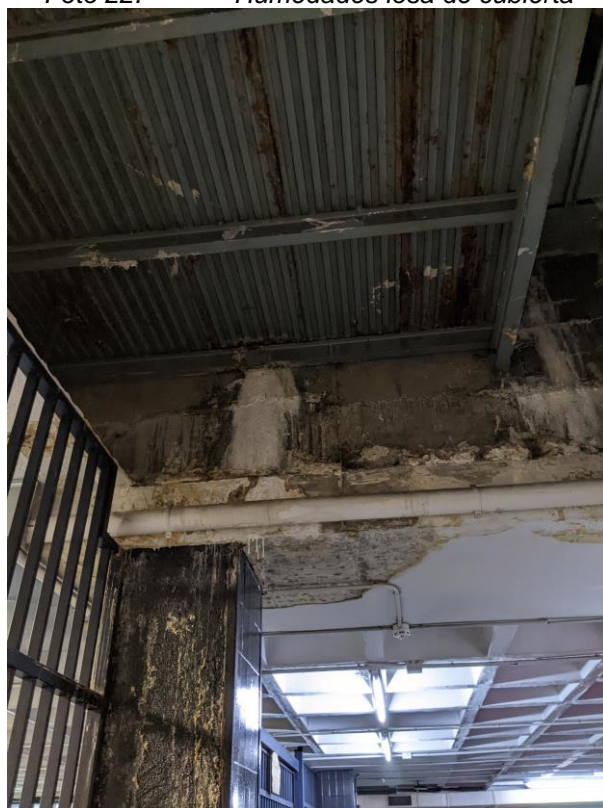
Foto 24. Humedades en cubierta (2)
