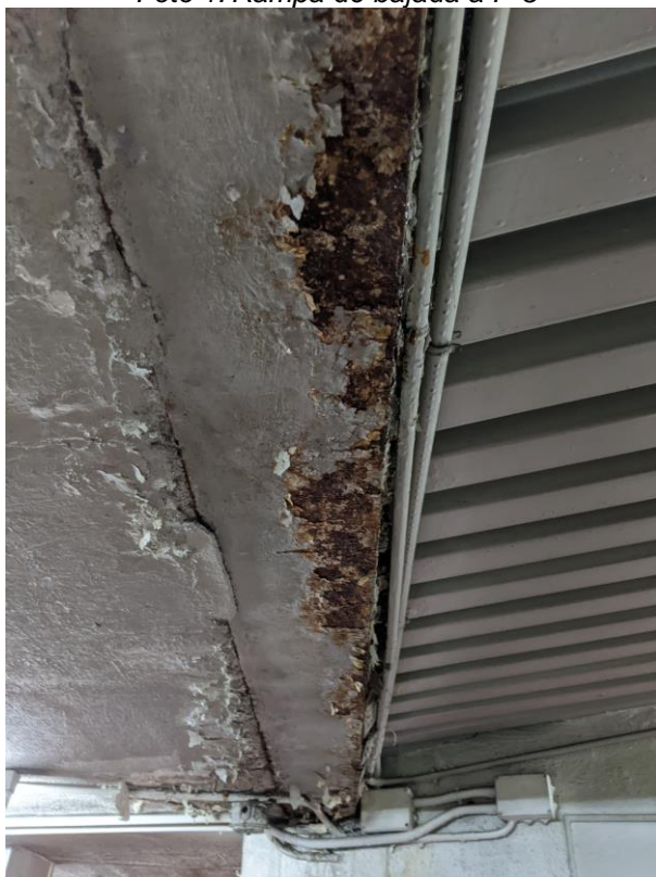
Foto 3. Estado junta en forjado – viga dintel
