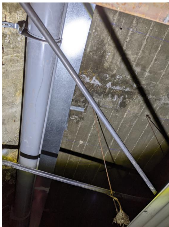
Foto 3. Vista del forjado unidireccional (liberado el falso techo a base de placas metálicas)
