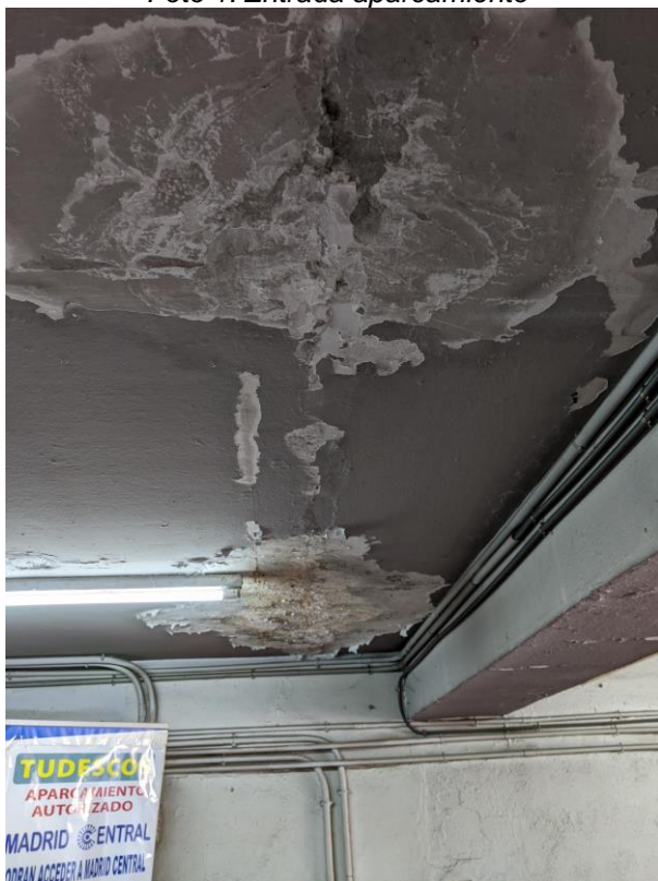
Foto 3. Humedades en losa de cubierta zona
