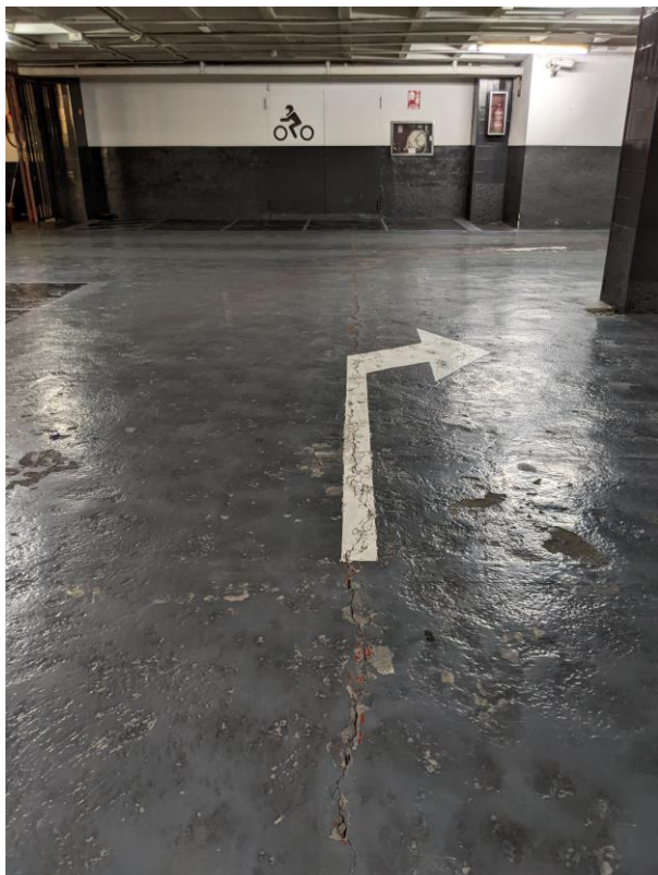
Foto 21. Fisura en pavimento
