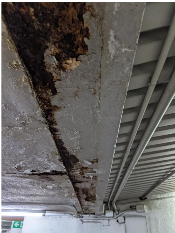
Foto 5. Viga dintel oxidada
