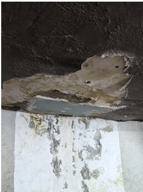
Foto 1. Humedades final de rampa a P-2
