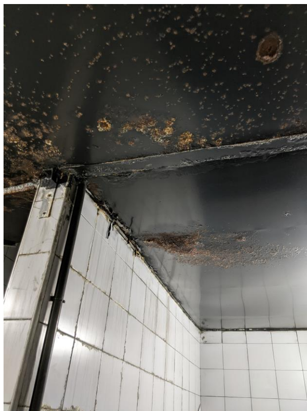
Foto 30. Estado de la chapa de la losa de escaleras
