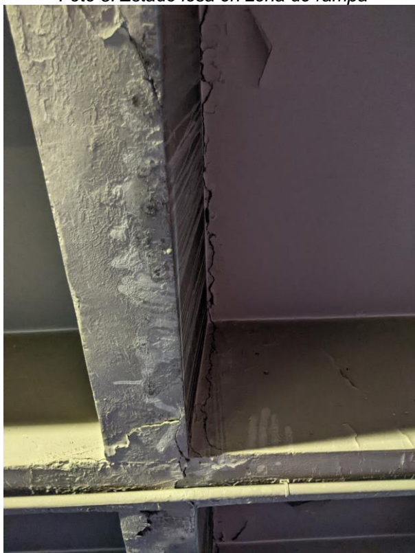
Foto 7. Fisura en forjado
