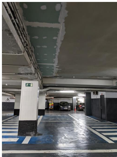
Foto 2. Forjado a nivel superior mediante vigas transversales y losa de compresión (tapadas por un falso techo)
