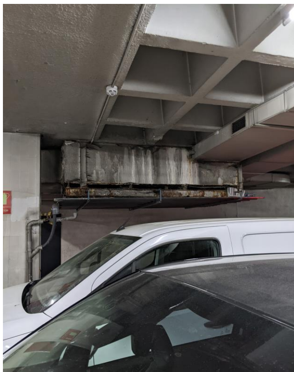
Foto 10. Punto de filtraciones de agua de la cubierta
