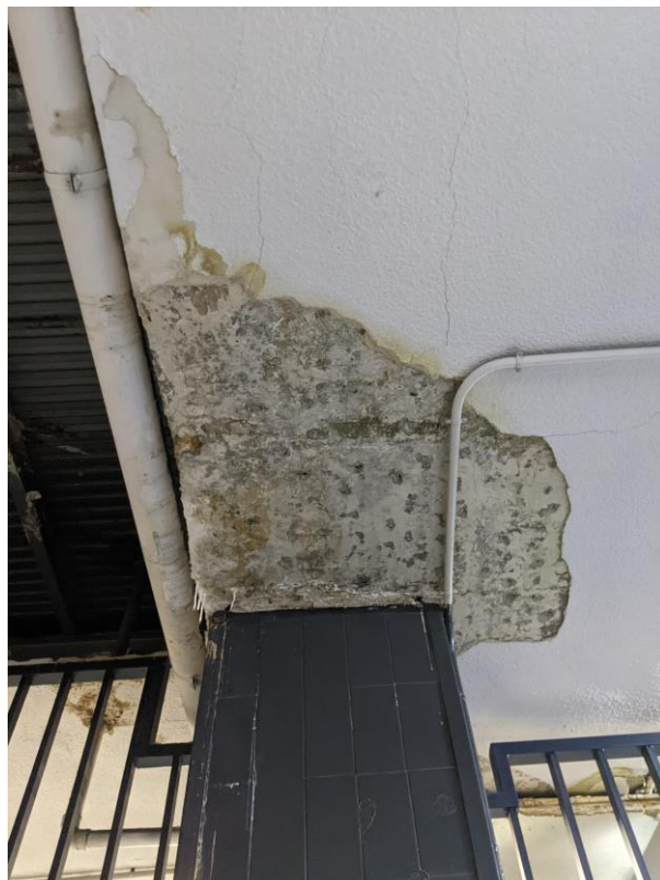
Foto 22. Humedades losa de cubierta
