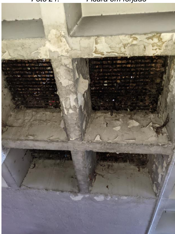
Foto 23. Estado forjado en rejilla de ventilación
