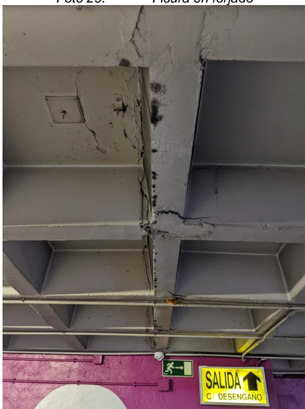
Foto 31. Fisura y pérdida de recubrimiento en forjado
