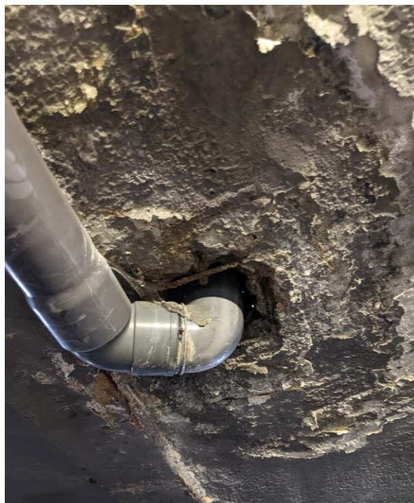
Foto 18. Estado de la losa y armaduras vistas
