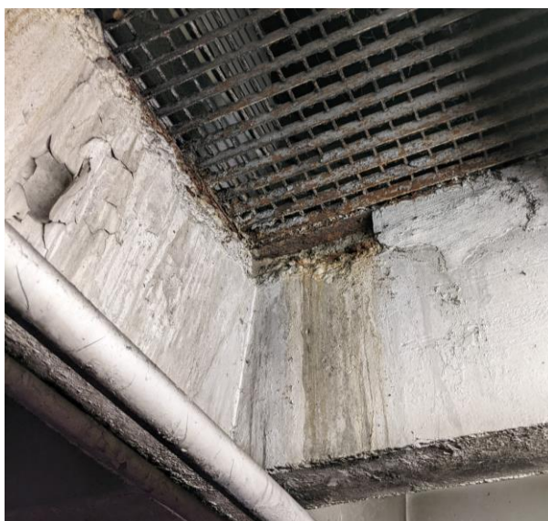
Foto 33. Pérdida de recubrimiento en el apoyo de la rejilla
