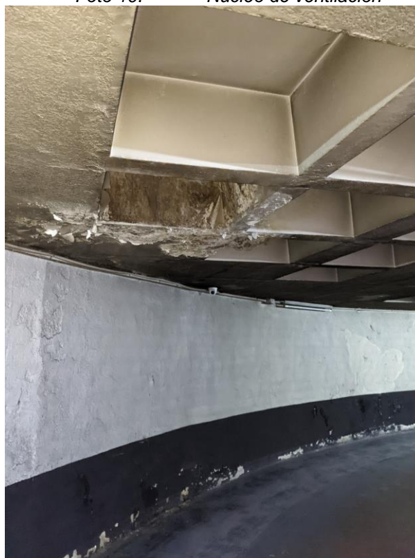
Foto 12. Humedades en forjado en zona de giro
