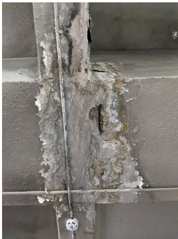
Foto 15. Armadura transversal a la vista
