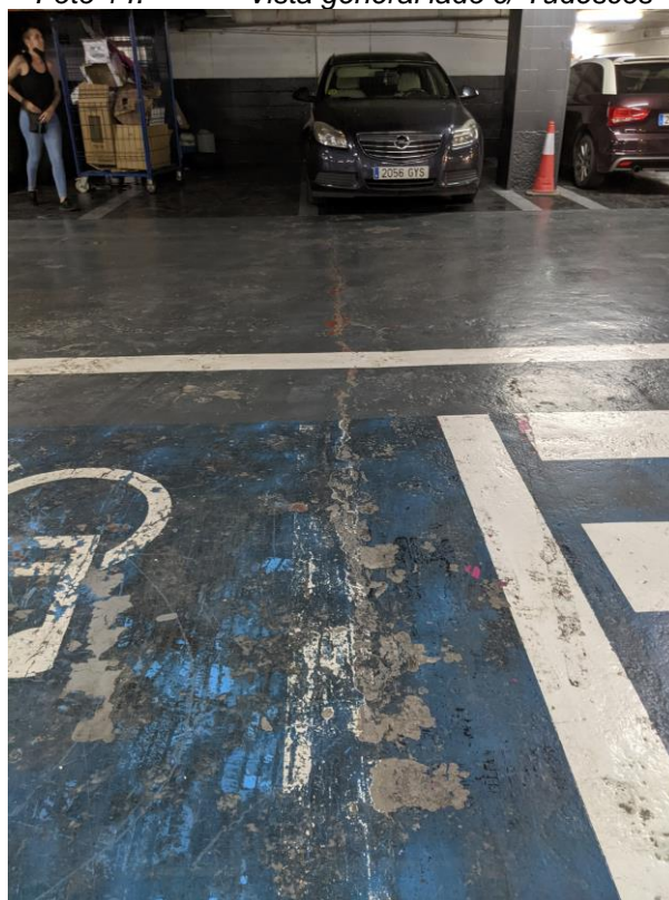
Foto 16. Fisura en pavimento
