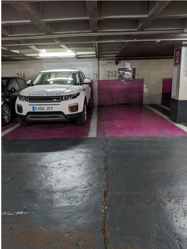
Foto 41. Fisura de pavimento
