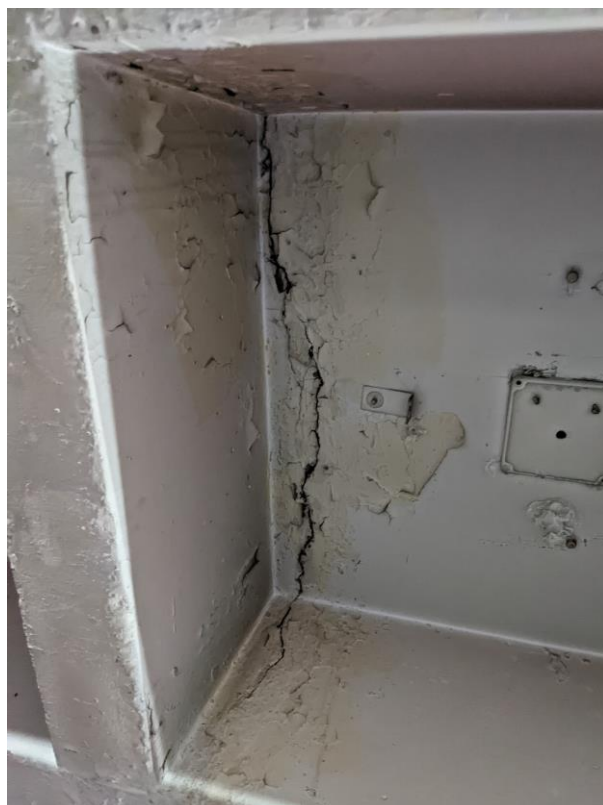
Foto 18. Fisura en forjado
