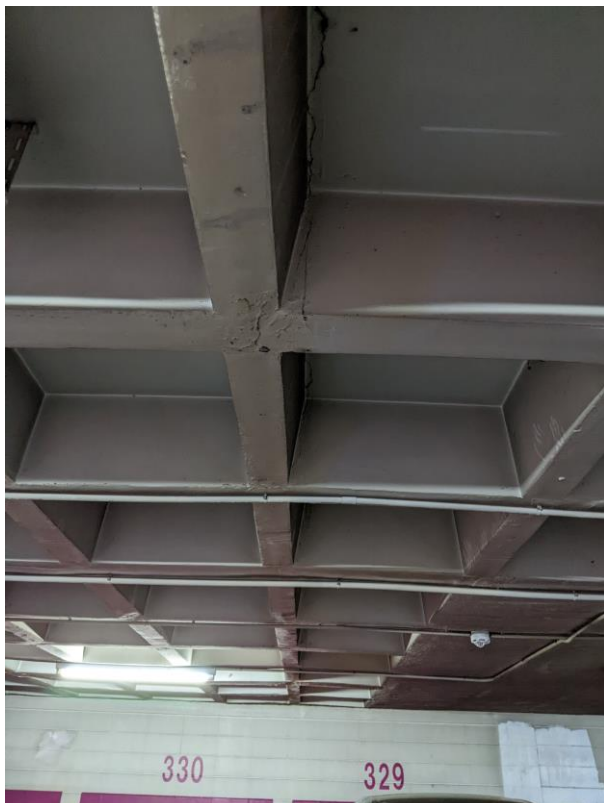
Foto 29. Fisura en forjado
