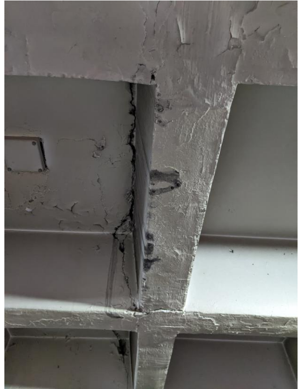
Foto 34. Fisura en forjado
