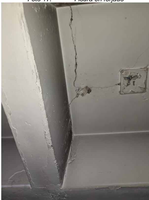
Foto 19. Fisura en forjado
