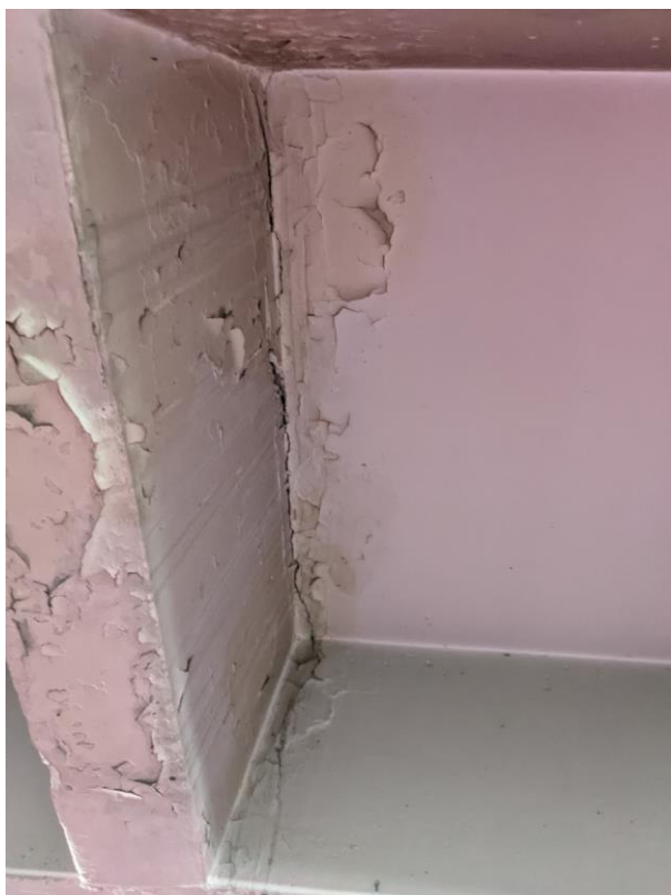
Foto 21. Fisura en forjado
