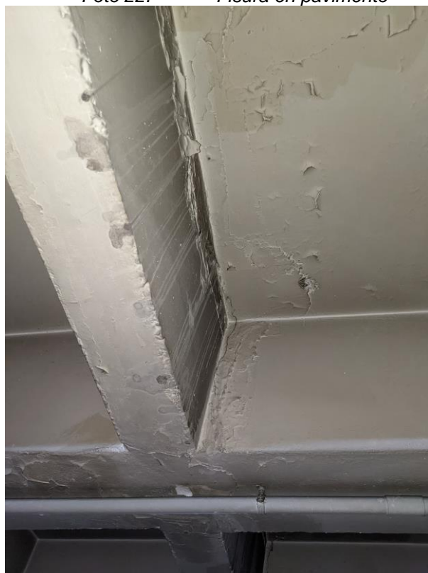
Foto 24. Fisura en forjado
