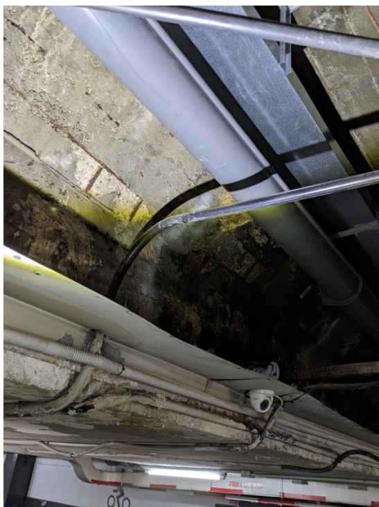
Foto 3. Vista del forjado unidireccional (liberado el falso techo a base de placas metálicas)
