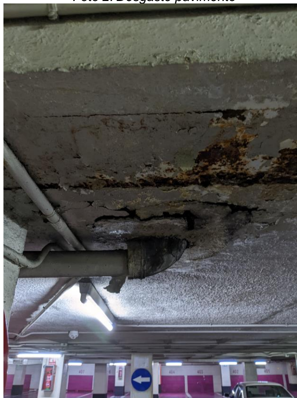
Foto 4. Estado losa encuentro rampa
