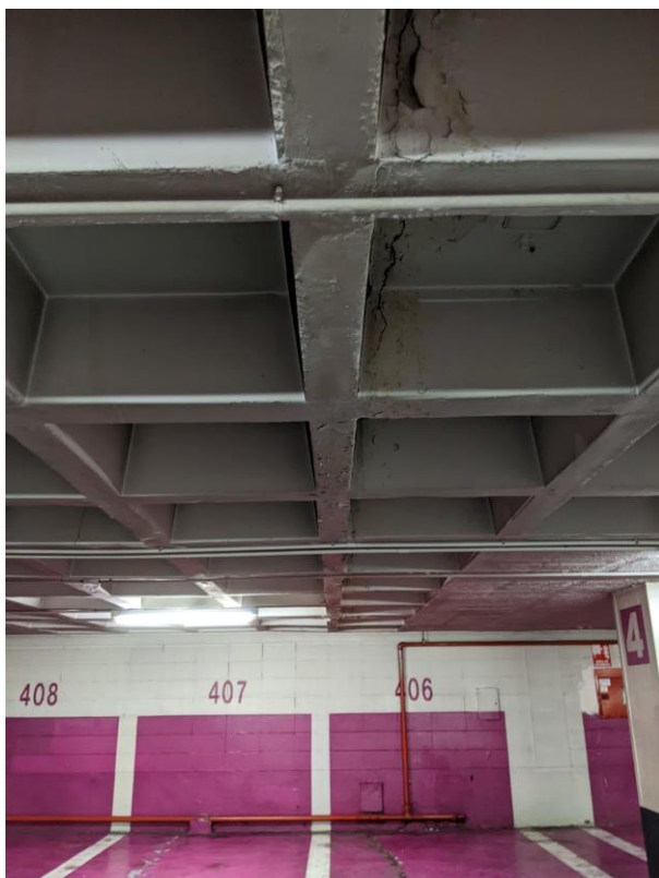
Foto 17. Fisura en forjado
