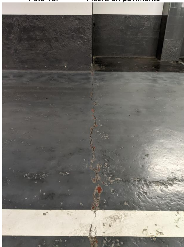
Foto 20. Fisura en pavimento
