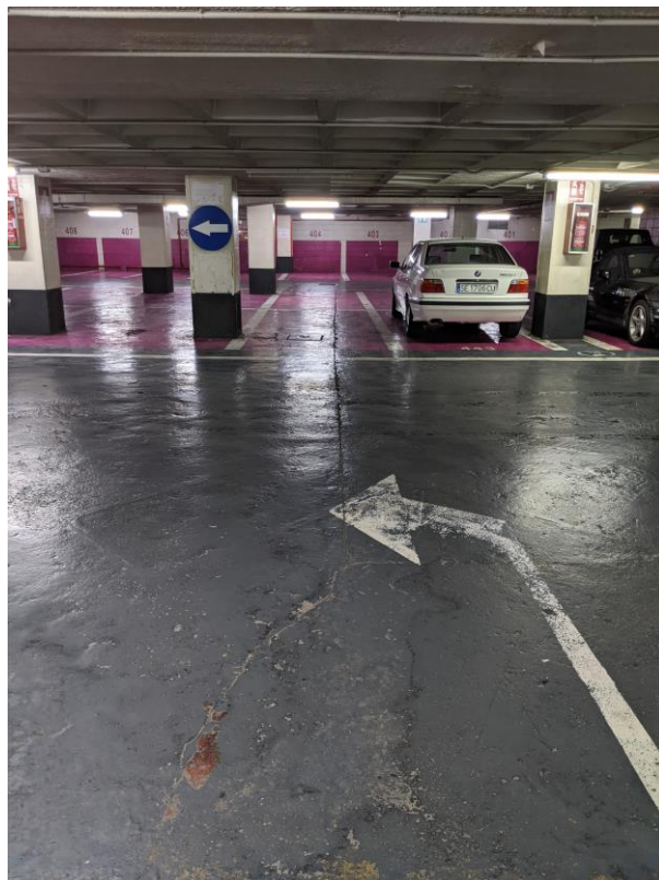
Foto 6. Fisura en pavimento
