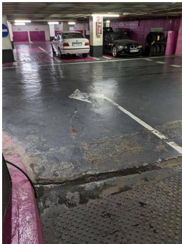
Foto 2. Desgaste pavimento
