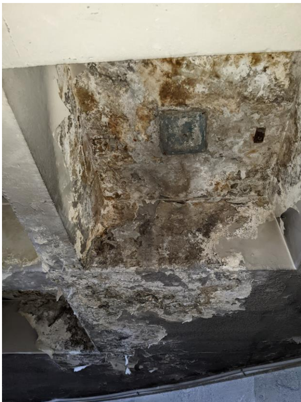
Foto 13. Humedades en forjado en zona de giro (2)
