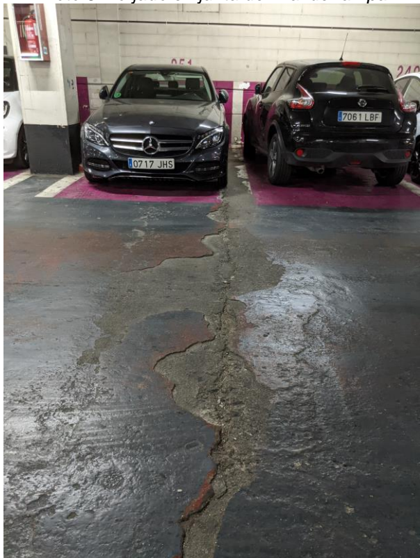
Foto 7. Fisura en pavimento
