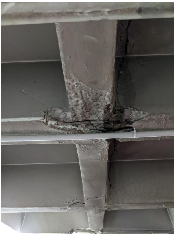
Foto 31. Fisura en forjado planta P-1
