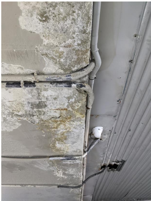
Foto 13. Humedades en cubierta
