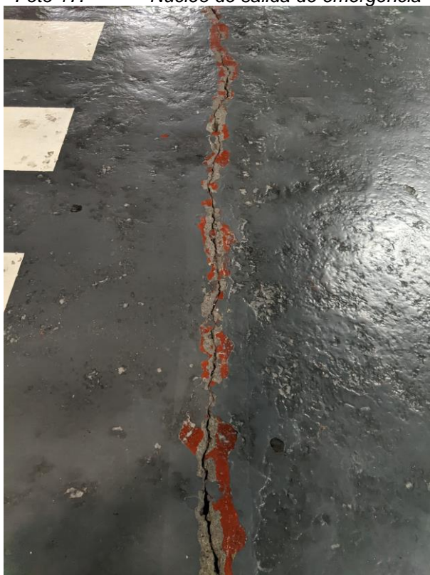
Foto 19. Fisura en pavimento
