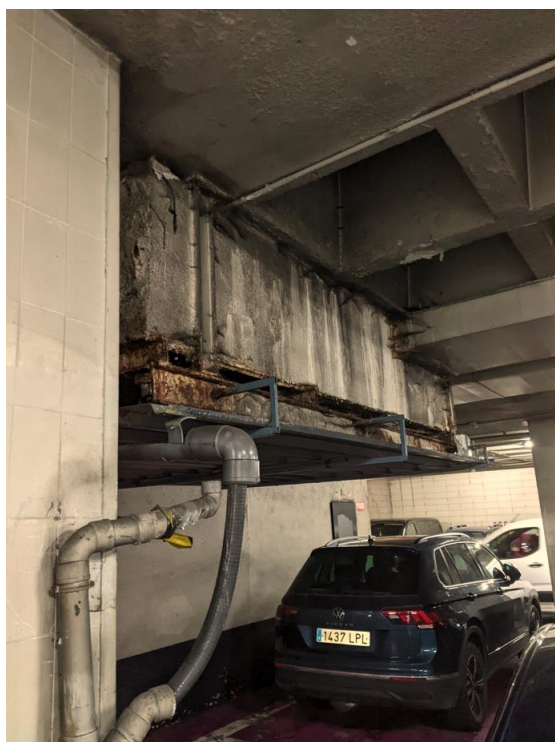
Foto 11. Sistema de drenaje "improvisado"
