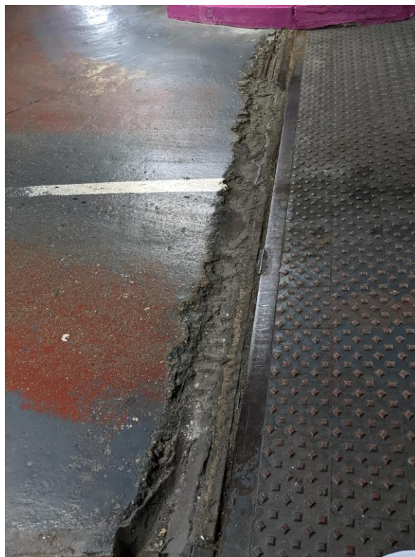
Foto 2. Estado junta de pavimento en rampa
