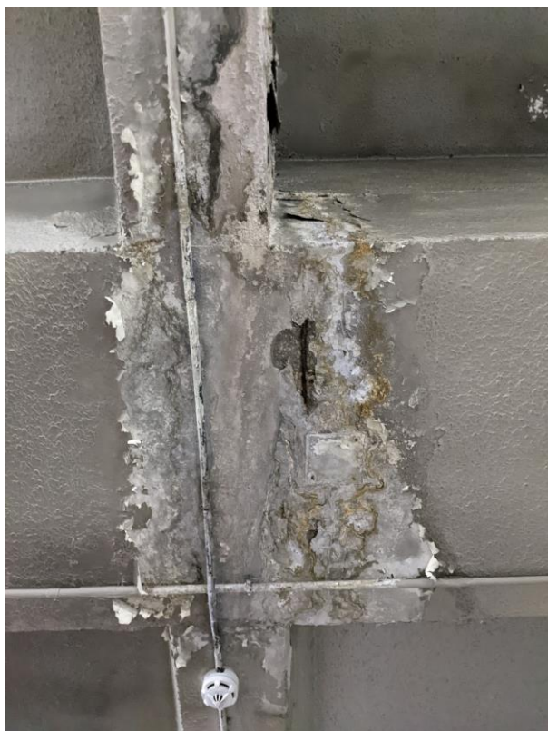
Foto 25. Pérdida de recubrimiento viga de rampa de entrada
