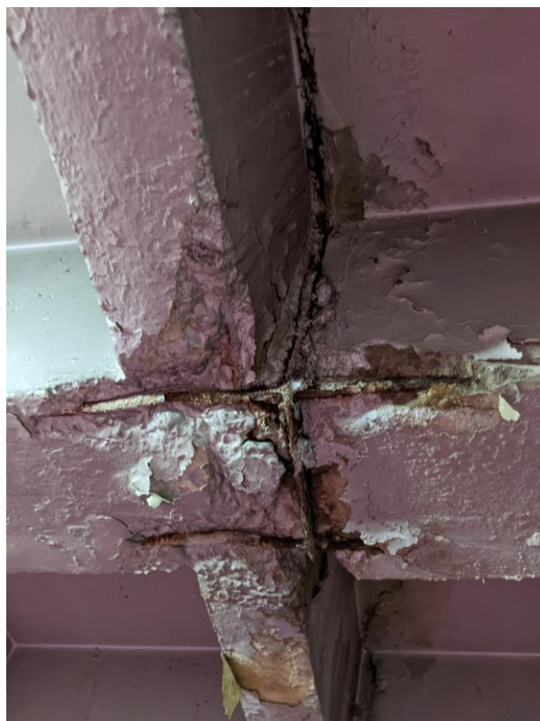
Foto 18. Pérdida de recubrimiento en nervios
