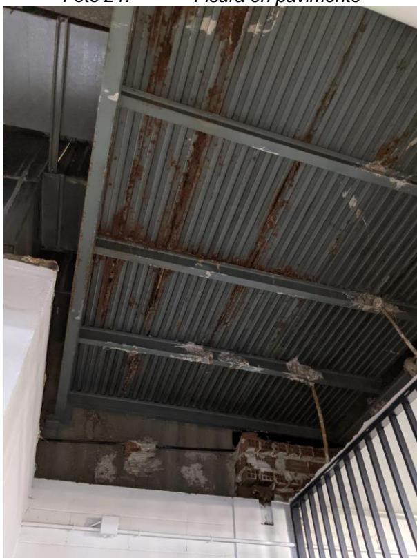
Foto 23. Humedades en cubierta
