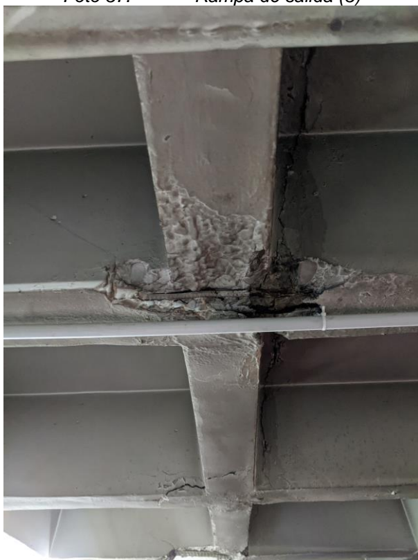
Foto 39. Pérdida de recubrimiento en nervio
