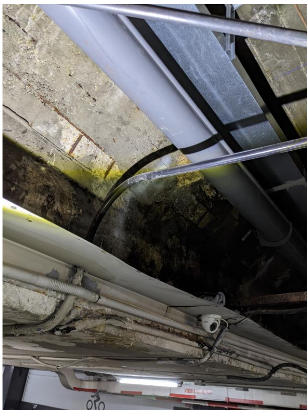
Foto 23. Humedades en viga de cubierta
