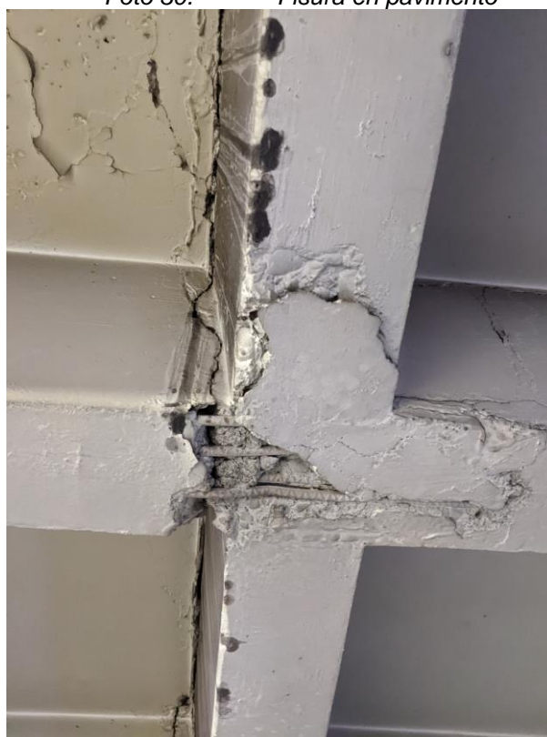
Foto 32. Fisura y pérdida de recubrimiento en forjado (2)
