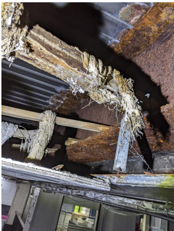
Foto 25. Viga metálica oxidada
