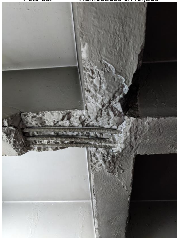
Foto 40. Pérdida de recubrimiento en nervio (2)
