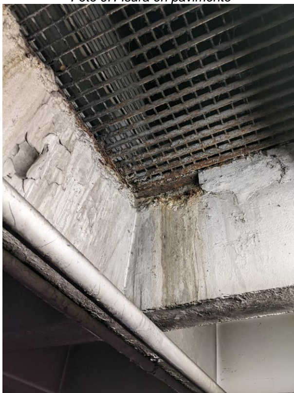
Foto 11. Pérdida de recubrimiento en rejilla de ventilación
